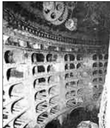
Уникальная фотография снарядного отделения под первой башней. Внизу виден электромотор привода горизонтальной наводки башни. 60 лет помещению были заполнены водой.
