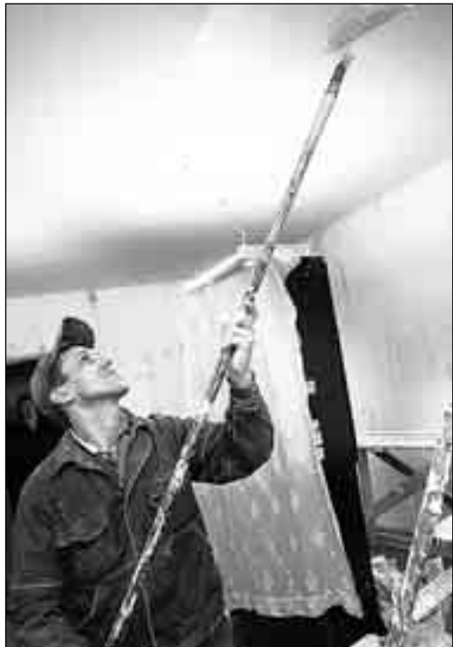
В опорном пункте №4 ОВД «Тропарево-Никулино» компания «Миракс-Сервис» проводит ремонт за свой счет
