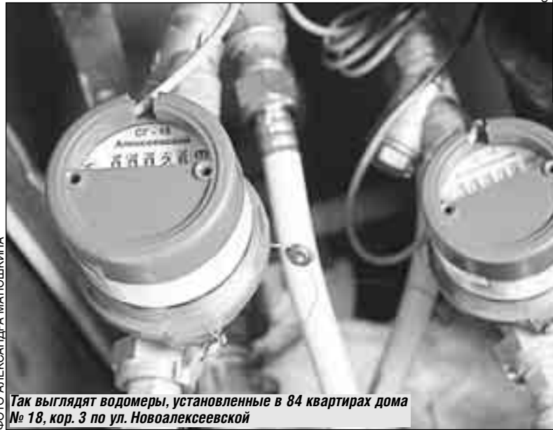
Данные о температуре, давлении, объеме воды поступают от счетчиков в ЕИРЦ через «Пульсар»
